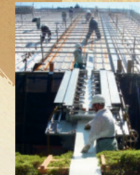
辰口丘陵公園の屋内テニスコート。レールと台車を駆使した屋根の改修工事は、業界の大きな話題に
